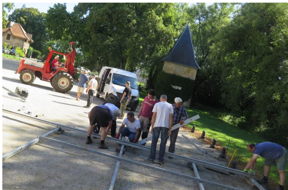
Les volontaires en plein montage des structures des chapiteaux. Photo F.-X. G.
